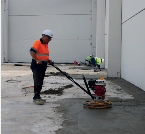
La truelle mécanique est servie avec un disque et un jeu de pâles de finition
